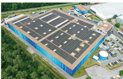
Die Logistikhalle Eco Hub verfügt über die größte PV-Gründach-Kombination Europas. © Laren Management GmbH
