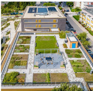
Das Sporthallendach einer Grundschule in Chemnitz wurde intensiv begrünt; es wird seitdem als Schulgarten genutzt. © Patrick Engert
