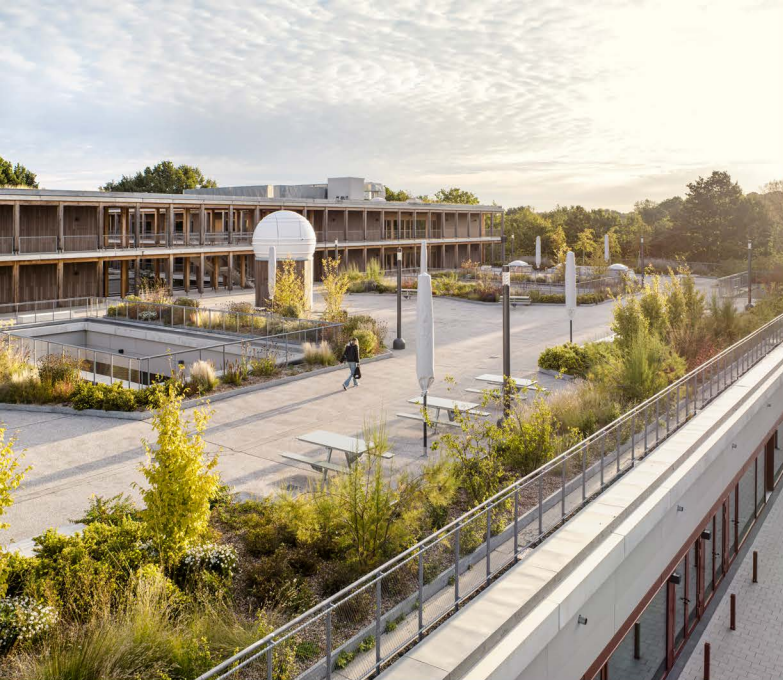
Die multifunktionale Dachlandschaft des Gymnasiums Langenhagen überzeugt mit 29.000 m 2 Nutzfläche und gehört zu den bestplatzierten Projekten des Wettbewerbs 2025. © HG Esch
